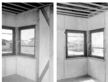
セララップ貼施工 ▶▶▶ 吹き込み完了後
