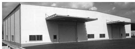
▲外壁:SD角波
