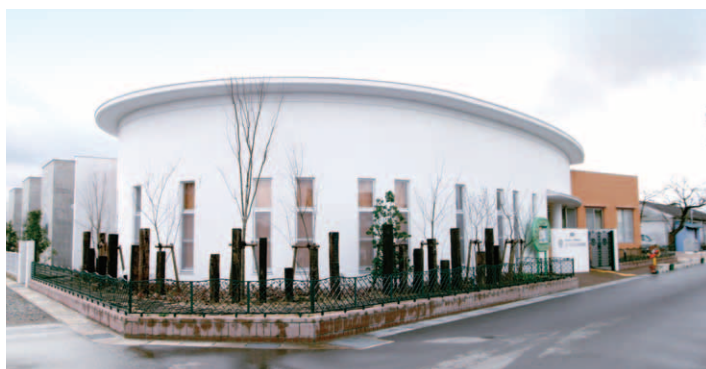
▲曲線と直線を融合させたモダンな園舎。
