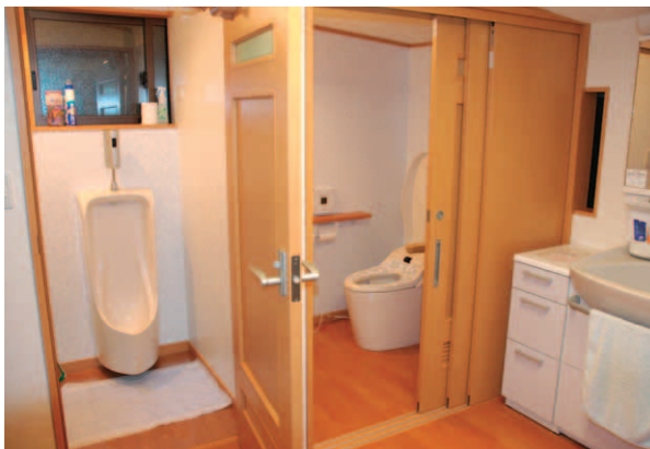
▲小便器と洋式便器を設けたトイレ。中央のホールに洗面所を設置。
