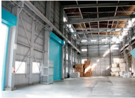
▲工場・倉庫の床は全面コンクリート。
