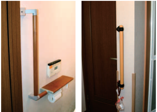
▲トイレ内部の手すり(左)とトイレ前の手すり(右)。縦向きの手すりを取り付けている。
