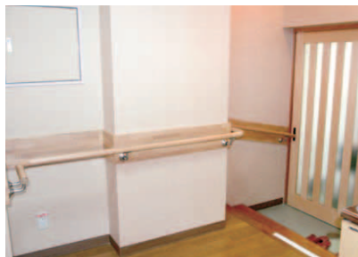
▲手すりを増設した通路。
