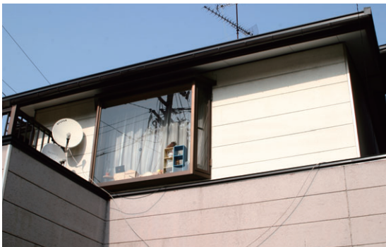
▲真新しい雨樋も目を引く。
