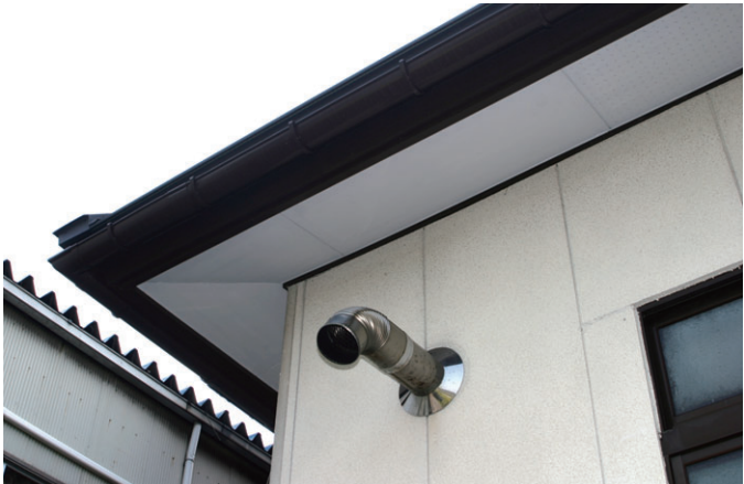
▲(上)グリーンの色合いが落ち着いた雰囲気を醸し出す大屋根。 ▲(下)軒裏や天井裏の換気に有効な有孔ベニヤを使用。
