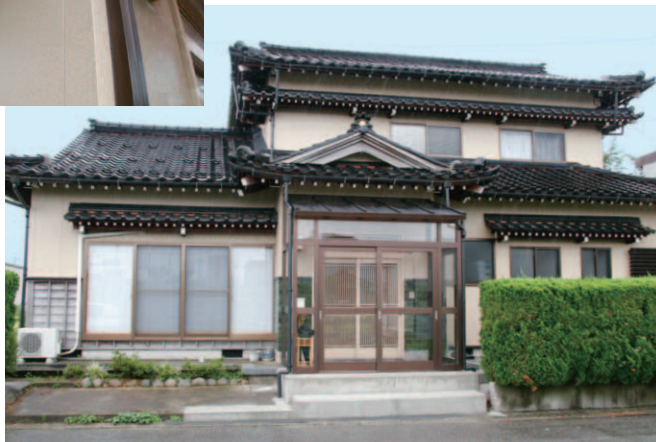
和風情緒を感じさせる外観。雨漏りの原因になった白漆喰の外壁にサイディングを張った。
