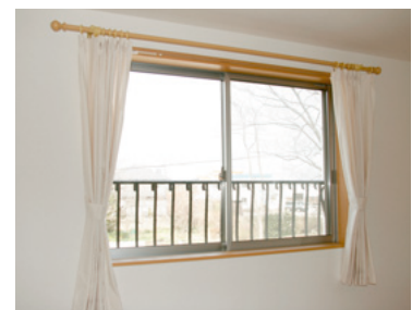
▲安全性に配慮した子ども部屋の手すり。
