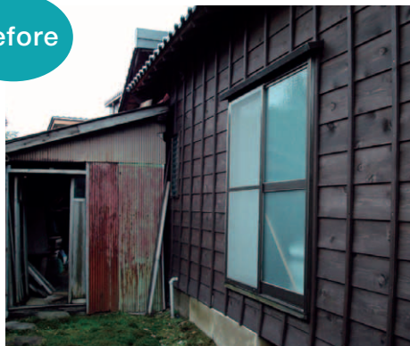
▲施工前の母屋の物置。
