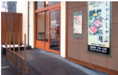
▲既存のスロープはそのまま活用された。
