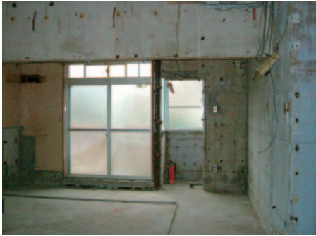
▲構造体だけになった空間。圧迫感のある梁。
