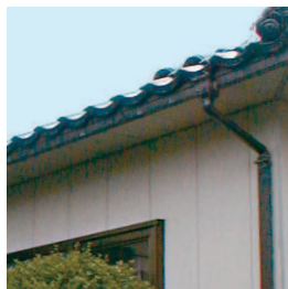
▲軒樋リフォーム前
