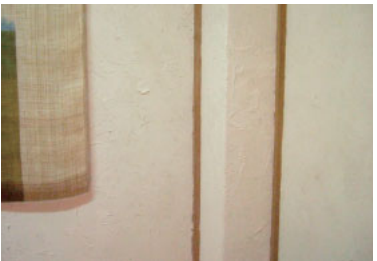
けいそうど ゆりかべ わらすき入りの下地用珪藻土の塗壁
