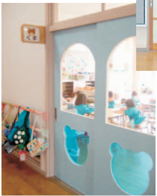
施工後の引き戸「クマ」
