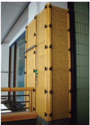
モルタルの壁を人工の竹垣で覆った。
