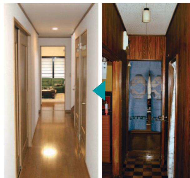
(左)リフォーム後の廊下。(右)リフォーム前の廊下 明るくなり、幅は広がった。奥に続く居間との境にある段差を取り除いた。
