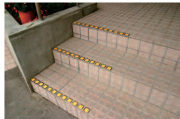
バリアフリーを考えたゆったりとした正面玄関(上)。階段には、段が見えやすいように黄色のマークを付けた(下)。
