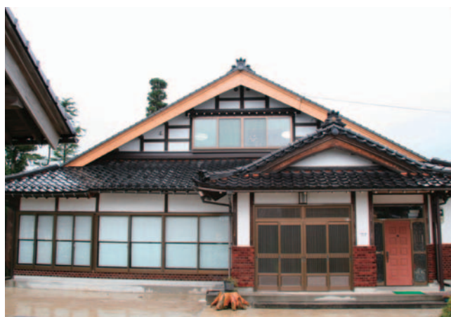
Y邸の吾妻建ちの外観。2階の妻面に子ども部屋の窓を大きく取り、外部にはバランスを見て化粧庇を付けている。
