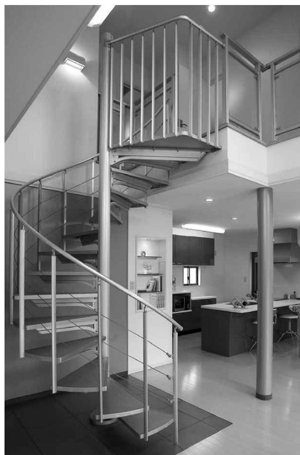
職人技を必要とするR曲げ加工の手すり。ステップを支える腕木にもR曲げ加工が施されています。
