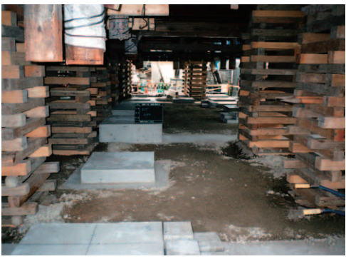
床部分は、根太上げをして改修し、再び元の位置へ戻した。改修中の根太上げをしているところ（左）。
