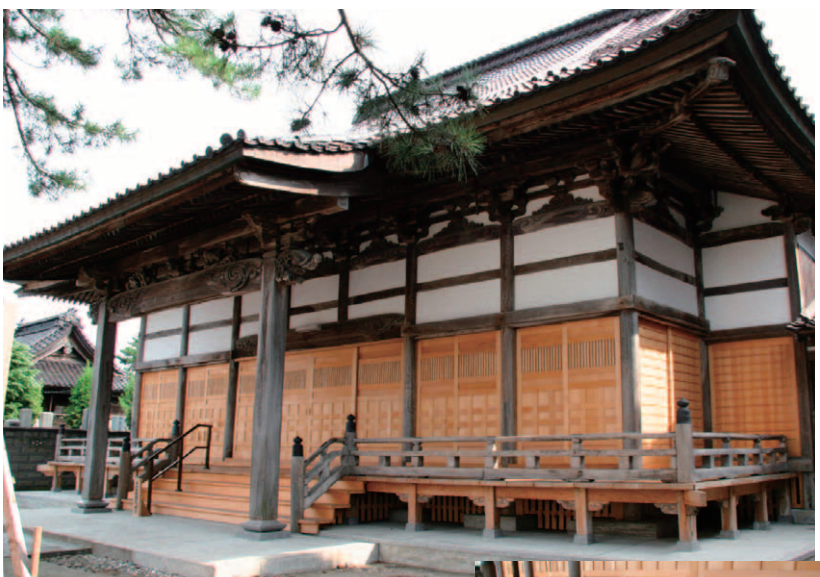
改修工事が完了した本堂外観（上）。県外からケヤキを調達して新しくした回廊と階段（右）。
