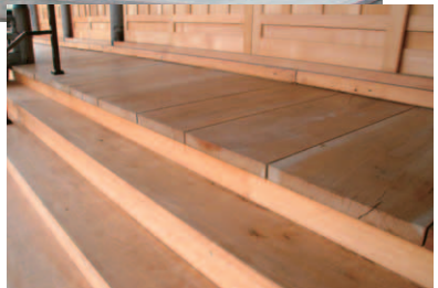
改修工事が完了した本堂外観（上）。県外からケヤキを調達して新しくした回廊と階段（右）。
