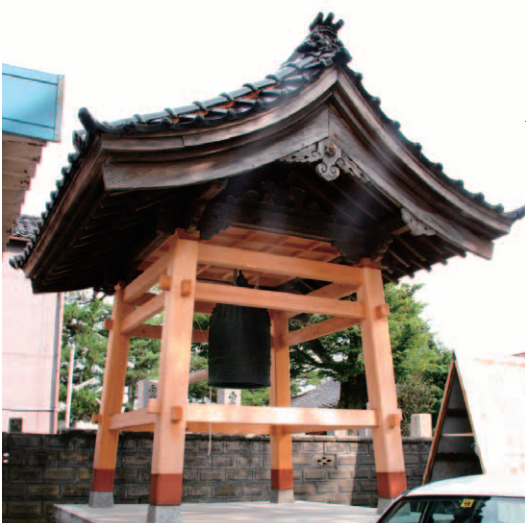
柱と天井部分を改修した釣鐘堂。屋根と鐘の重みだけで支える構造だという。
